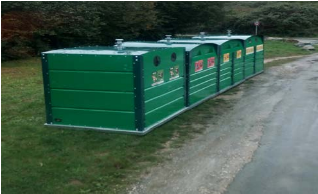
Bavans - Chemin de Sainte Marie – mis en place le 14/03/2019
