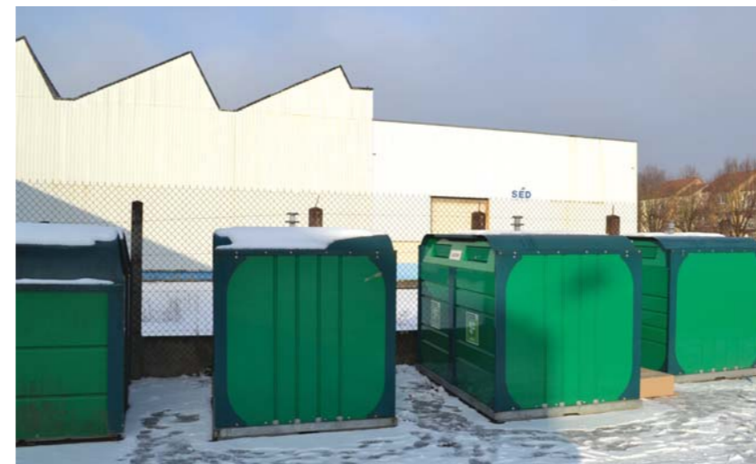
Le Point R est désormais installé sur le parking de la SED.
